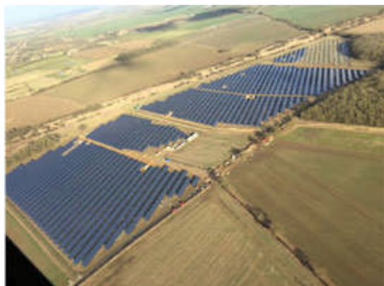
Photovoltaik-Kraftwerk von Athos Solar in Bedfordshire/UK
